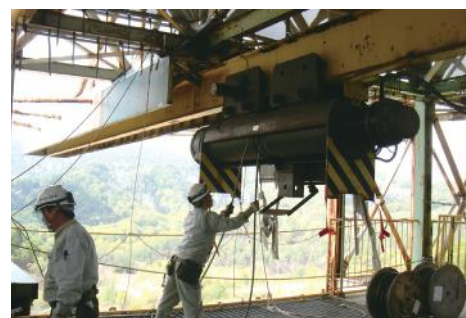
■クレーン整備
