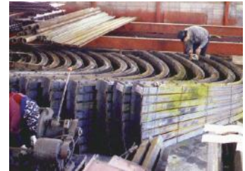
坑枠製造開始(昭和39年)
