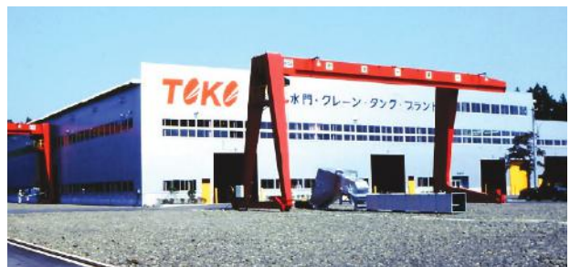
本宮工場(インフラ鉄構事業部・工事業部)
