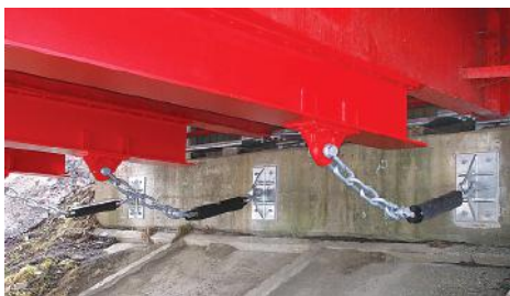
■比内中央橋補修工事(秋田県)
