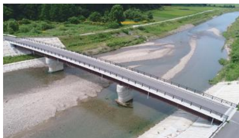
■西扇田橋新設架設工事(秋田県)
