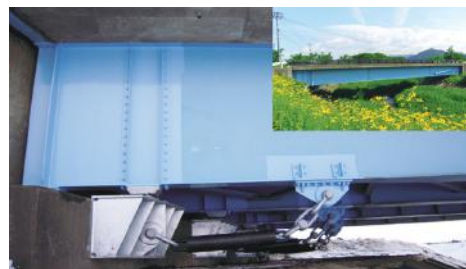
■大茂内橋補修工事(秋田県)
