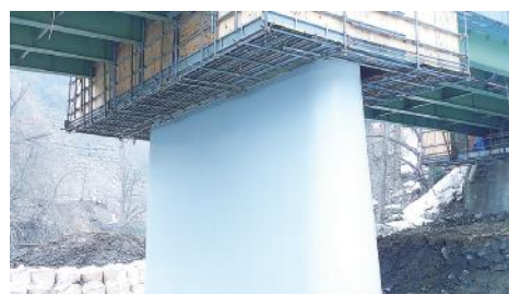
■積ヶ岱橋補修工事(秋田県)
