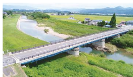
■二井田橋補修工事(秋田県)
