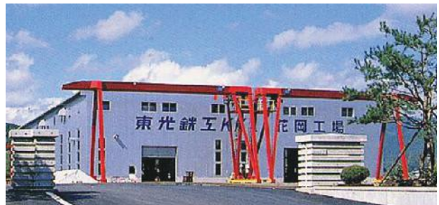
花岡工場(鉄骨事業部)
