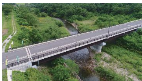
■長者森橋新設架設工事(秋田県)
