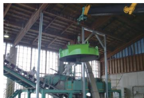
■機械器具設置工事
