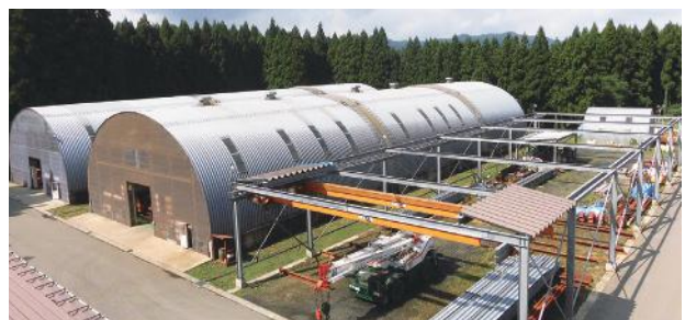
本宮工場(ドーム事業部)
