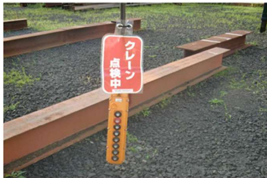
●クレーン点検中(ペンダントスイッチ)
